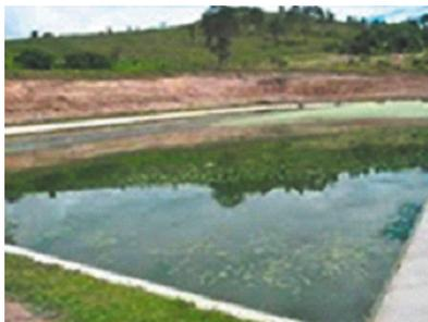
**Fig. 2.35** Laguna de oxidación del agua
