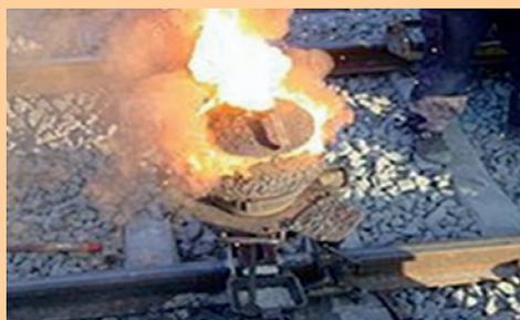
**Fig. 4.9** Soldadura de railes de líneas mediante el proceso de la termita
