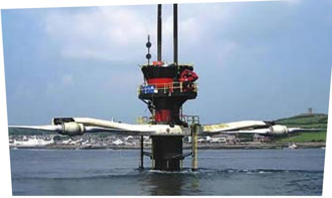
**Fig. 4.13** Turbinas y generador para el aprovechamiento de la energía mareomotriz
