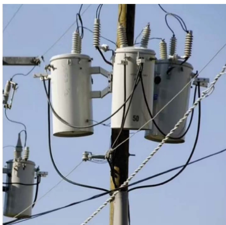
Fig. 3.62 Transformadores reductores del tendido eléctrico
